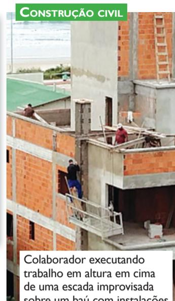
Colaborador executando trabalho em altura em cima de uma escada improvisada sobre um baú com instalações precárias, sem adoção de medidas de controle como cinto de segurança conectado a ponto de ancoragem e demais EPIs necessários
